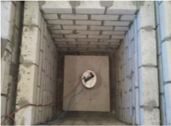
Рис. 3. Загальний вид постаменту сейсмостанції «Одеса-Місто» в ОНМУ та запис нею землетрусу із зони Вранча 25.04.2018 р.
